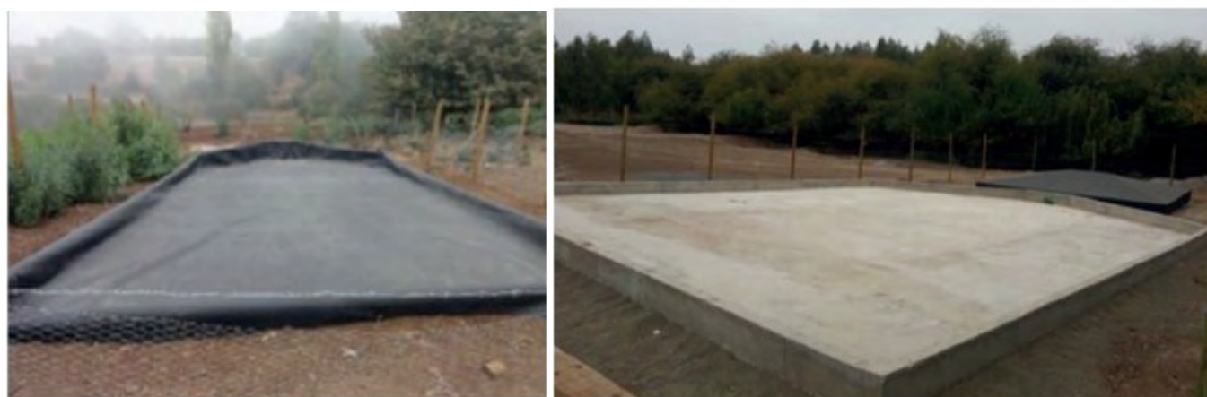
Figura 3. Áreas de captación utilizadas (izquierda: Geomembrana; derecha: Hormigón)
