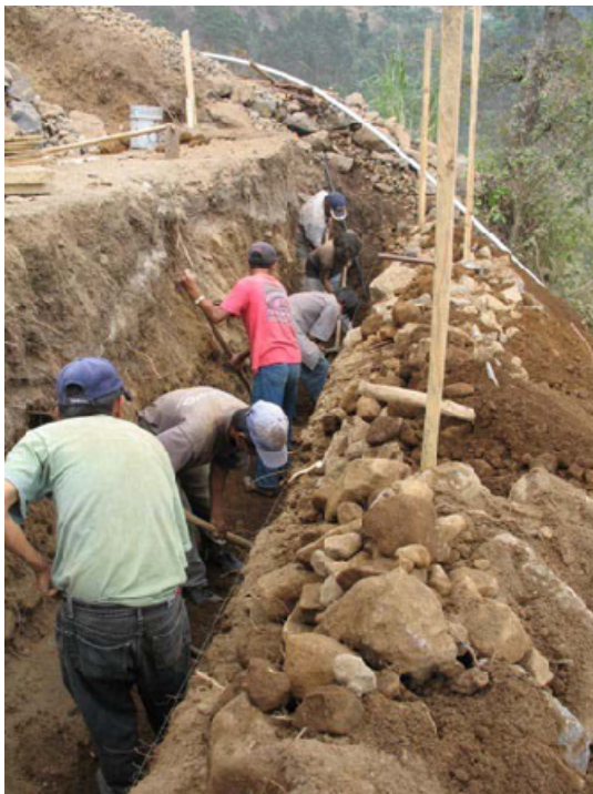
Construcción de zanjas para conducciones con mano de obra de los usuarios
