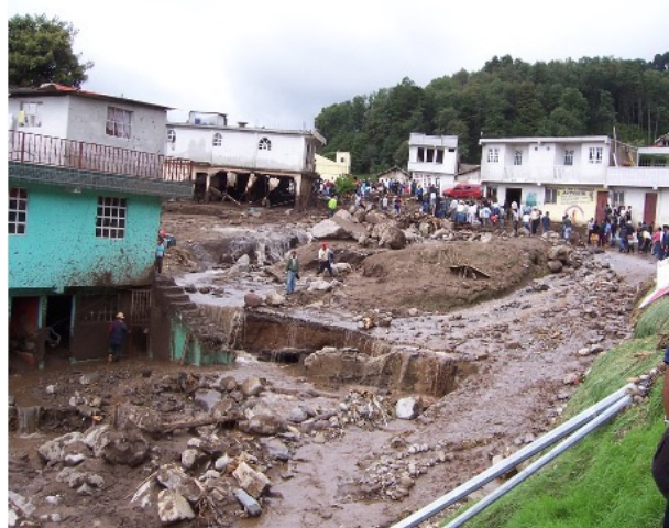
Destrucción de viviendas e infraestructura urbana
