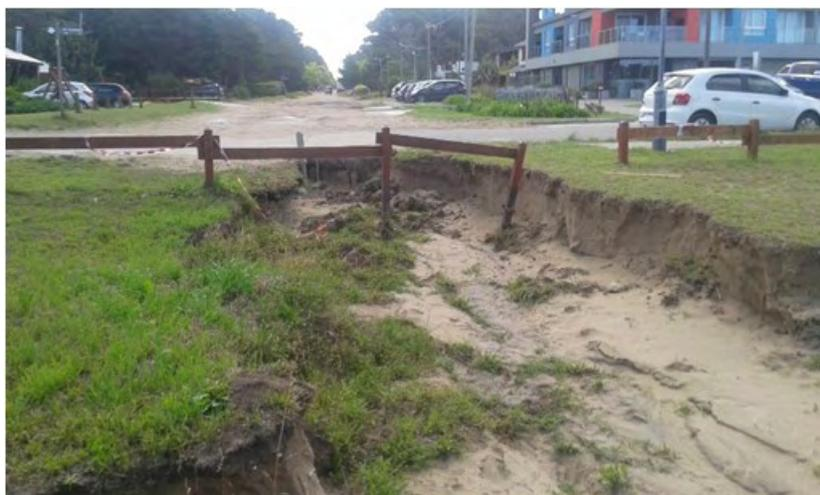
Figura 7. Erosión por descarga directa desde calzada con pendiente hacia el litoral. Pérdida de recarga del acuífero
