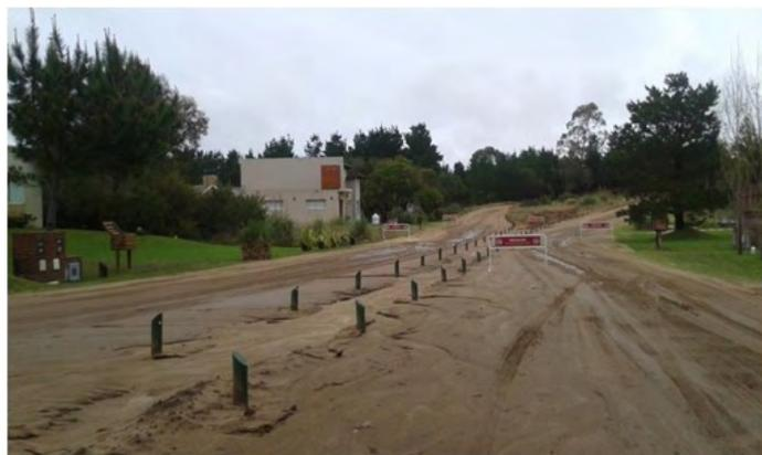
Figura 20. Estado de la calzada y el badén al 8h de finalizada la precipitación
