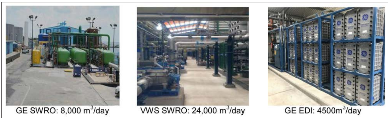
Figure7. The actual desalination technology at WEB Aruba
