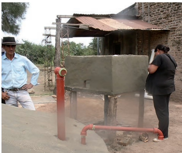
Figura 12a. Alternativa de bomba manual para aljibe construida con polipropileno. (Basán Nickisch y Sánchez, 2016)
