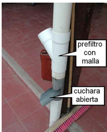
Figura 5. Sistema de prefiltrado y cuchara
