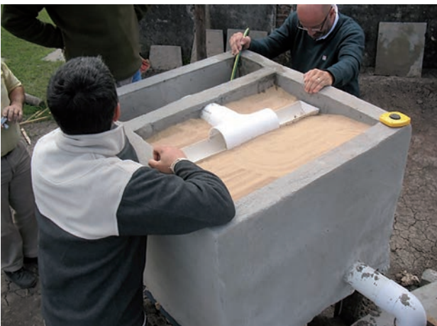
Figura 9. Filtro ya cargado con sistema vertedor en la superficie de la arena
