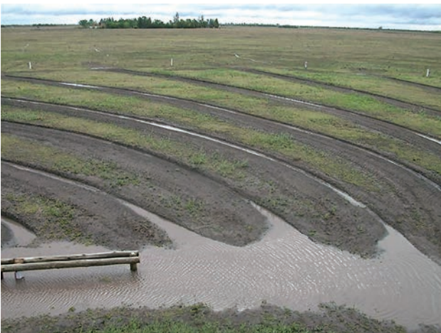
Figura 11. Área de "cosecha" de agua de lluvia compuesta por colectoras radiales helicoidales que culminan en un anillo concentrador donde se encuentran las perforaciones doble propósito
