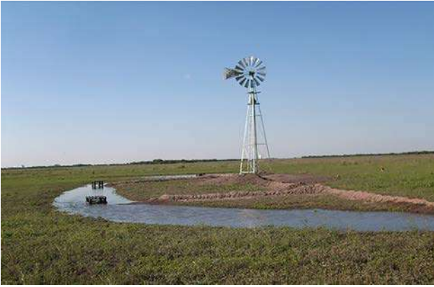
Figura 4. Anillo concentrador del agua de lluvia para efectuar la recarga al acuífero con las perforaciones en el Sistema A
