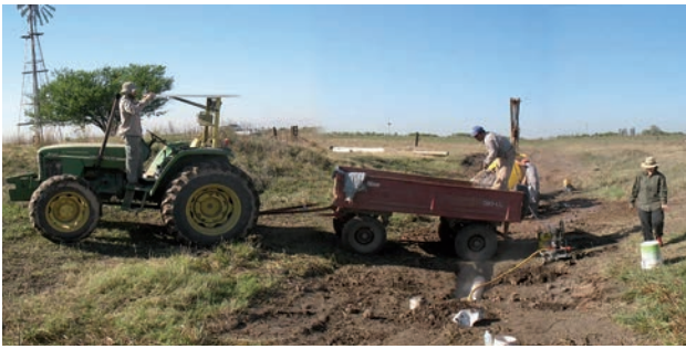
Figura 7. Mejoras sustanciales al Sistema B con implementación de perforaciones “doble propósito” en el interior de la represa con chupadores flotantes
