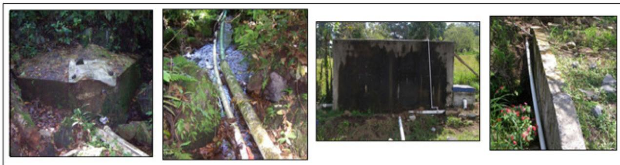
Figura 2. Principales estructuras del acueducto de Buenos Aires. De izquierda a derecha: obra de captación del manantial, tubos madre, tanque de almacenamiento y red domiciliaria
