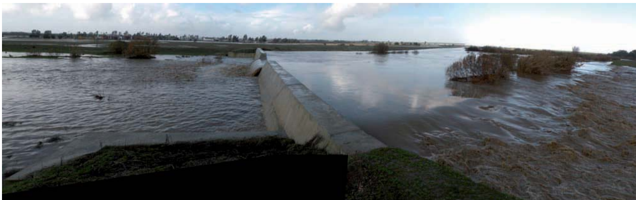
Figura 5. Reparto del caudal de avenida de 234,9 m 3 ·s -1 en el Dique 1 construido sobre el arroyo del Partido a las 12:50 horas locales del día 4-01-2010. Se estima que en dicho momento pasan por el vertedero frontal al arroyo del Partido 27,5 m 3 ·s -1 ; por el vertedero lateral hacia la superficie de inundación 174,5 m 3 ·s -1 y los restantes 32,9 m 3 ·s -1 se desvían hacia el arroyo de la Cañada del Pinar por la curva de remanso generada aguas arriba del paramento frontal del Dique 1.
