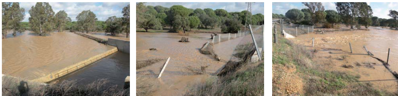
Figura 7. Secuencia de imágenes de la avenida del 24-12-2009 que muestran de izquierda a derecha: a) el muro de tierra situado en el margen izquierdo del Dique 2; b) el tránsito de la corriente de avenida hacia la sección del paso de fauna y c) la salida del flujo de avenida del paso de fauna, para dirigirse al cauce del arroyo de la Cañada del Pinar aguas abajo del Dique 2.
