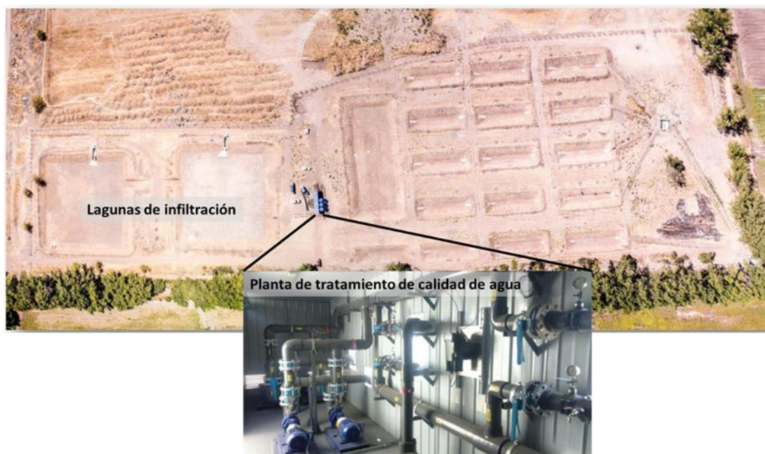
Figura 3.8 Vista área de sistema piloto de recarga artificial construido en La Pintana, RM. (Fuente: SCM, 2017)
