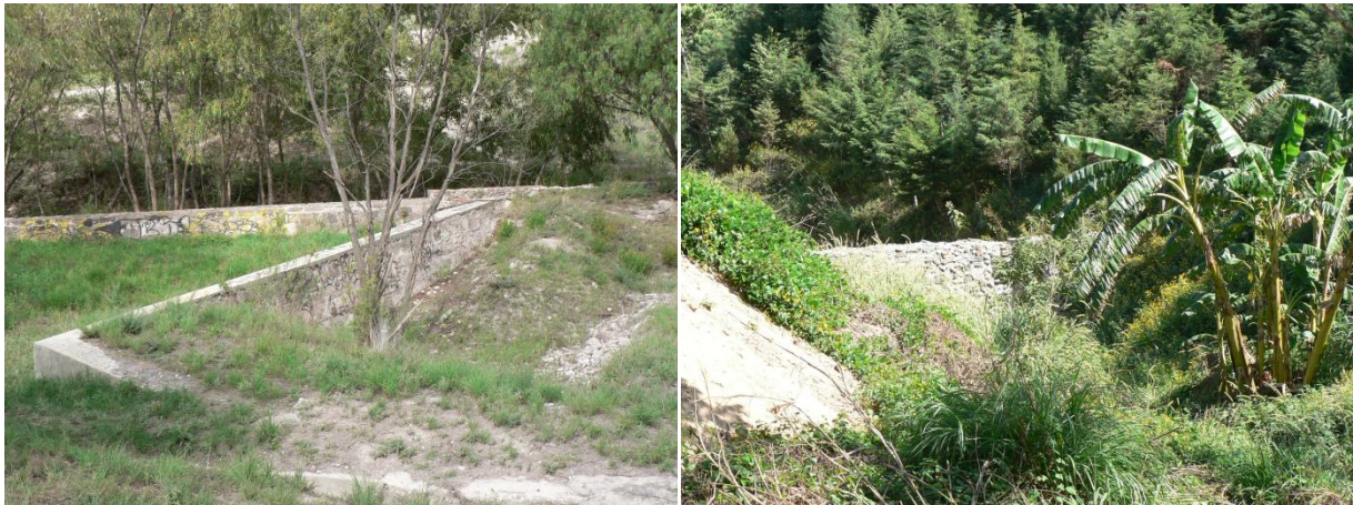
Fotografía 6. Muros de piedra (P=0.60)
