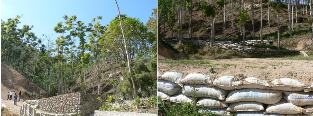
Fotografía 7. Sistemas de terrazas en sentido de la pendiente del terreno (P=0.35)
