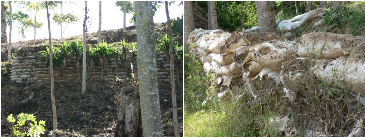
Fotografía 9. Barreras de muros vegetativos (P=0.45)
