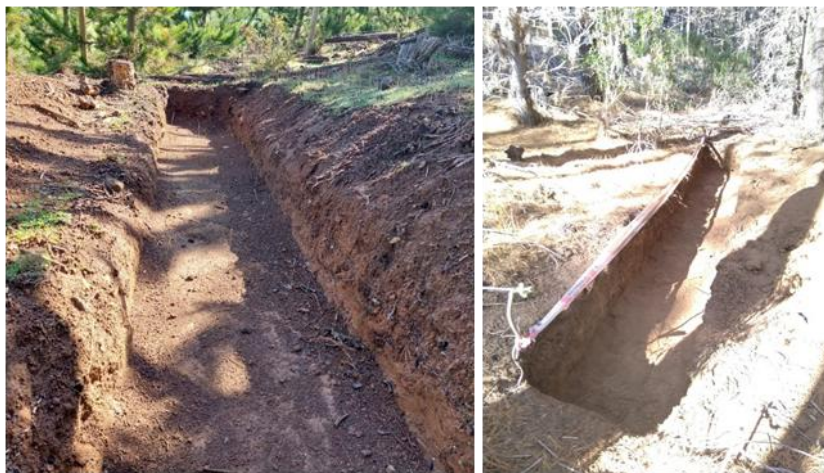
Figura 6. Trampa de erosión construidas en el estudio.
