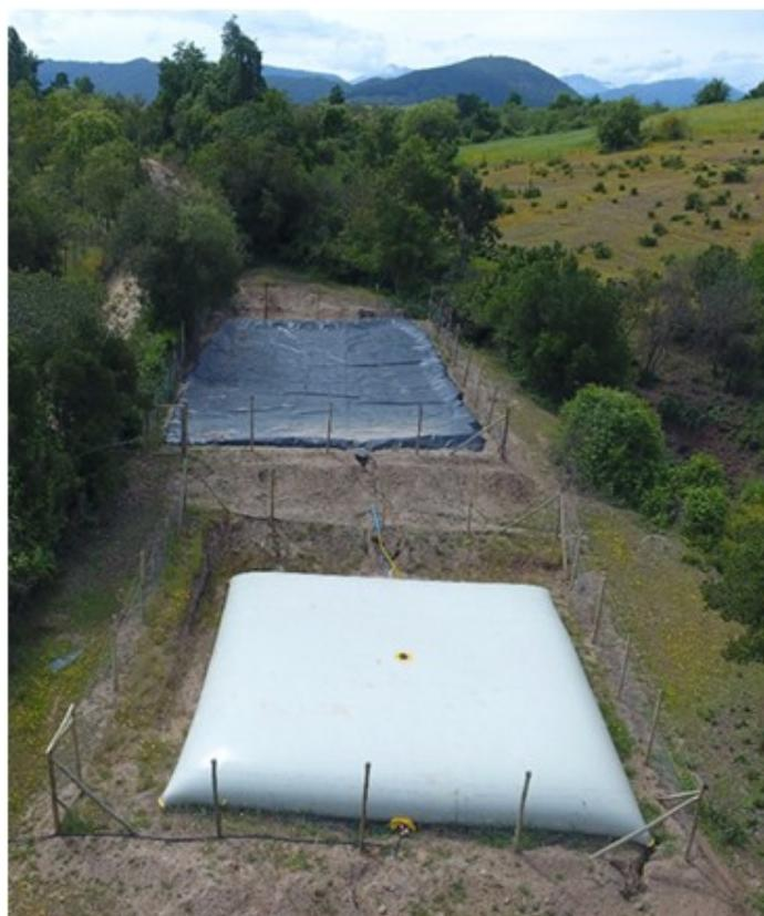
Figura 4. Sistema de Captación de Aguas Lluvias instalado en la Región del Maule (sector Rincón de los Muñoces, Región del Maule), con área de captación de geomembrana y estanque flexible de 80 m<sup>3</sup>
