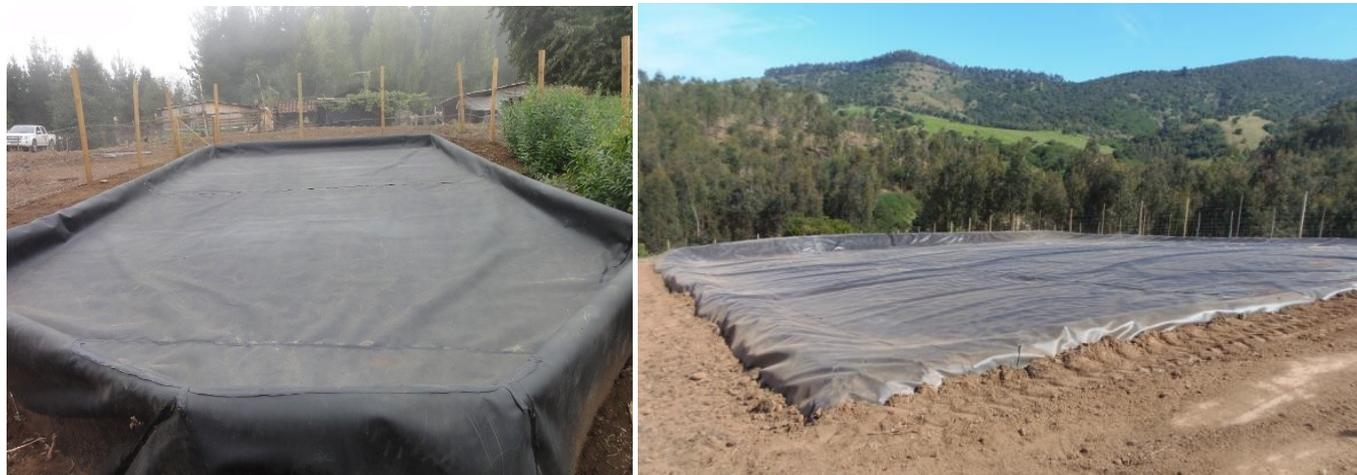
Figura 2. Anclaje de la geomembrana: enterrada en una zanja perimetral (izquierda) y armazón de polines (derecha)
