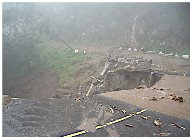
Deslizamientos de laderas
