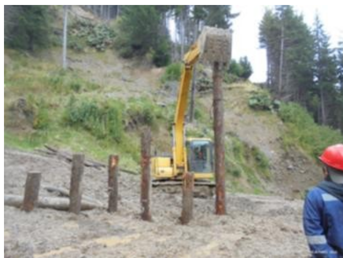
Figura 9. Hincado de pilotes en el área de flujo del deslizamiento. Foto W. Alfaro, 2018
