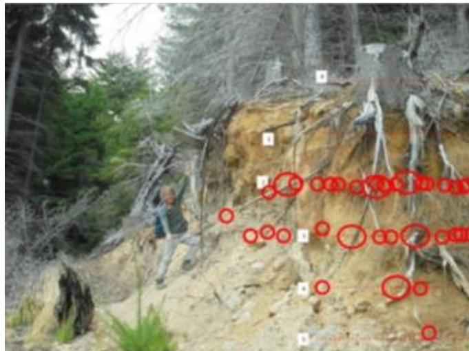
Figura 10. Análisis de la distribución de raíces en Talud 0 del área de deslizamiento. Foto W. Alfaro, 2018.
