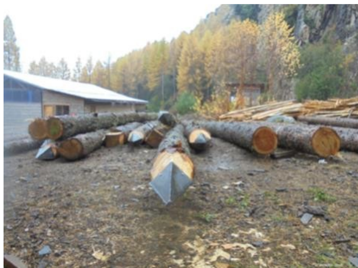
Figura 8. Pilotes de madera de Larix decidua con protección de la punta. Foto W. Alfaro, 2017.
