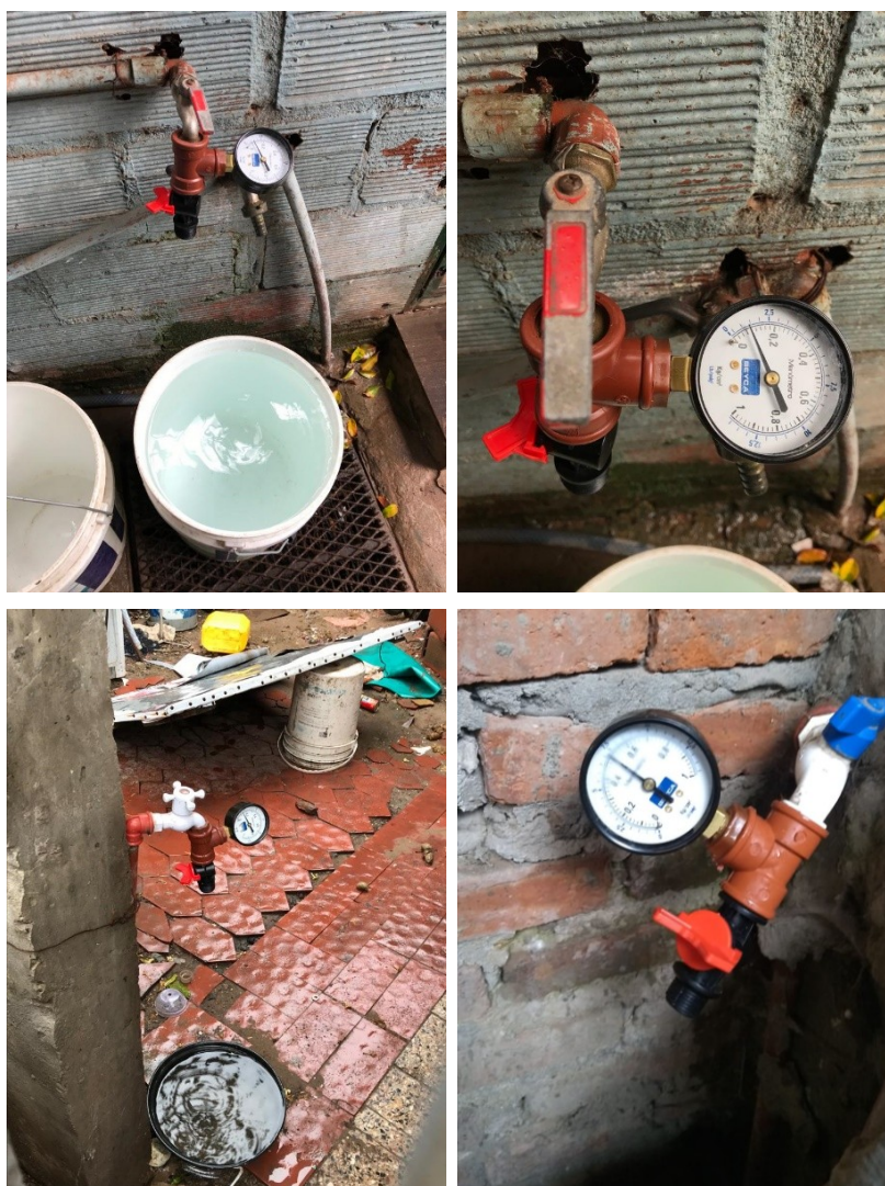
Figura 4. Imágenes de la medición de presión en canillas conectadas a las redes públicas de agua del barrio
