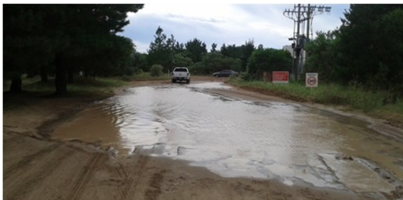
Figuras 5. Zona inundada en una zona de acceso
