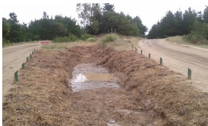
Figura 19. Comportamiento del dren de absorción luego de una precipitación de 52 mm con una tasa máxima de 22 mm/h
