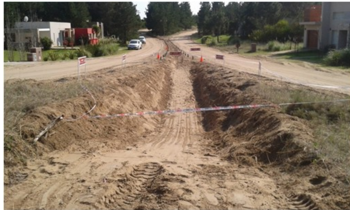
Figura 15. Dren de absorción realizado en espacio común dónde descarga el badén
