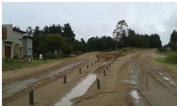
Figura 18. Comportamiento del badén luego de una precipitación de 52 mm con una tasa máxima de 22 mm/h
