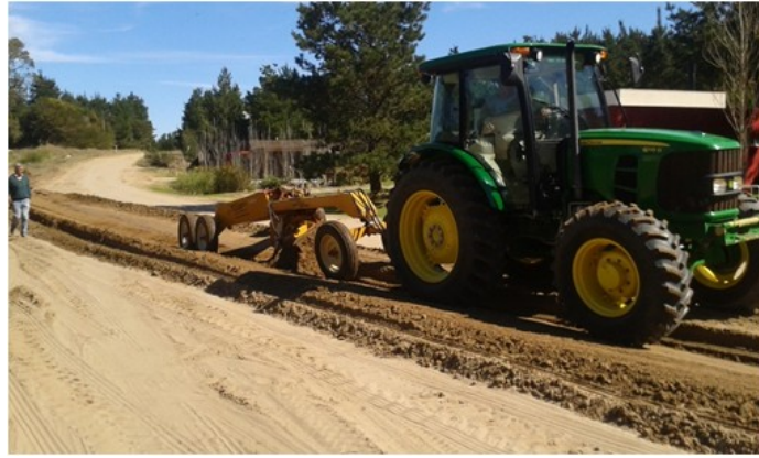
Figura 14. Hoja de arrastre realizando badén central para transporte de agua
