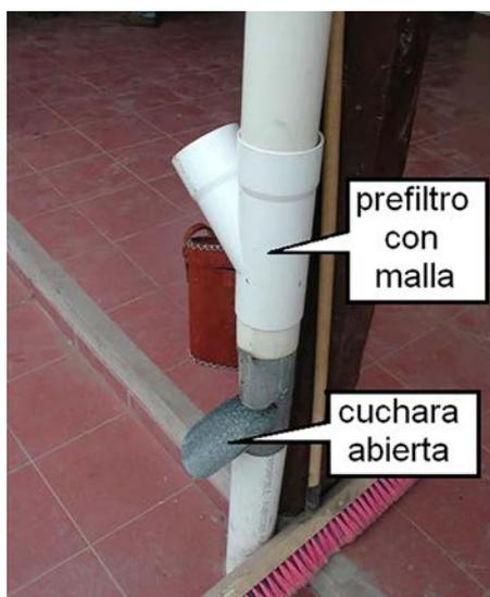
Figura 5. Sistema de prefiltrado y cuchara
