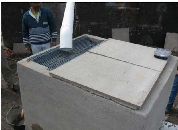
**Figura 10.** Filtro completo con tapas de protección para el filtro de arena
