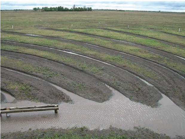
Figura 11. Área de “cosecha” de agua de lluvia compuesta por colectoras radiales helicoidales que culminan en un anillo concentrador donde se encuentran las perforaciones doble propósito
