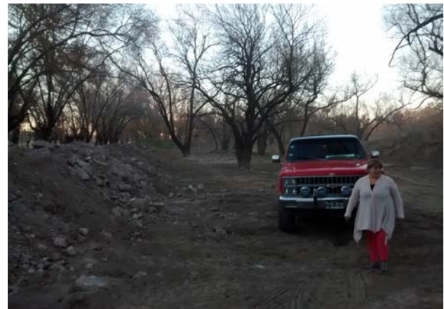
Figura 16.- Construcción de terraplenes en las cercanías del predio "El Yuyal" en el barrio Vista Verde de Villa María en el mes de Julio de 2015.
