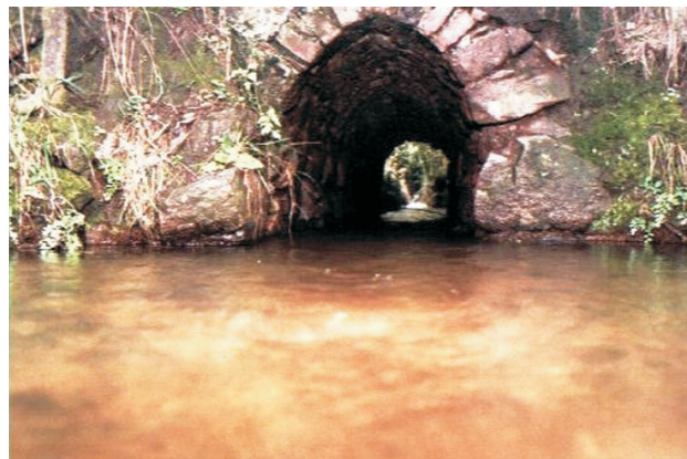
Figura 11. Vista de un tramo de acequia abovedada y revestida.
