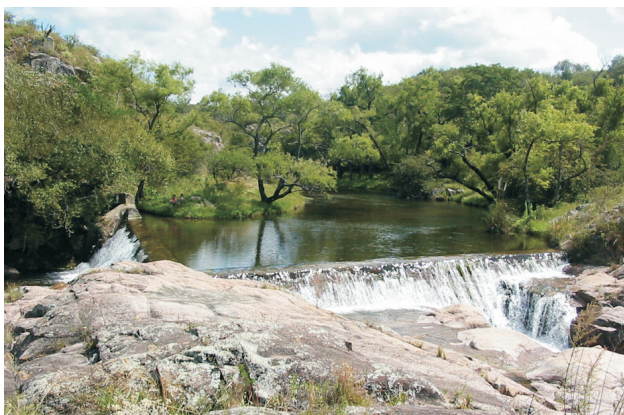
Figura 10. Vista del azud y sus dos cierres. La obra de toma se encuentra en el extremo derecho del muro de cierre construido sobre margen derecha
