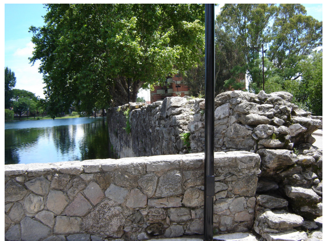
Figura 6: Encuentro entre el muro nuevo y el original en la zona aledaña al reloj.
